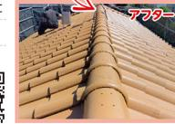
築30年の一戸建て。雨漏りするとSOSを頂き、調査したところ、セメント瓦1枚が経年劣化で破損していました。
